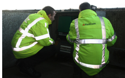
De renovatie van dertien spoorbruggen is uitgevoerd door medewerkers van RailCom.
